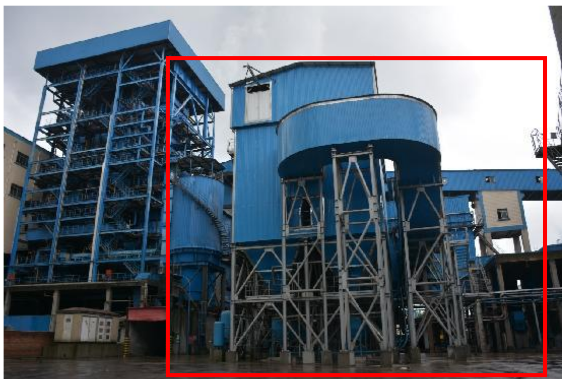
图 4.1-1 1#焚烧炉配套尾气处理系统（1）
