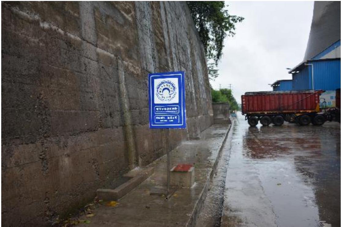
图 4.2-1 地下水监测井
