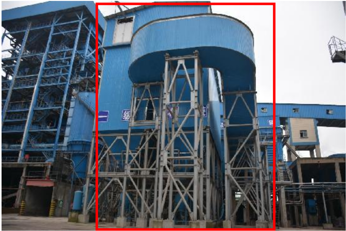
图 4.1-4 1#焚烧炉配套布袋除尘器
