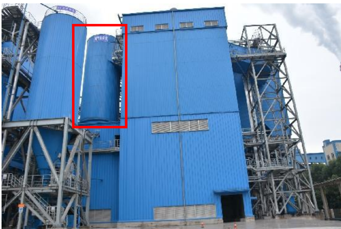
图 4.1-9 2#焚烧炉配套烟气反应塔
