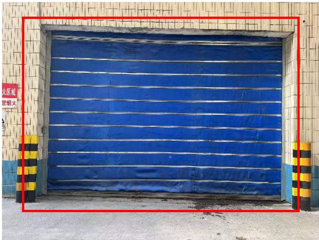
图 4.1-22 固废仓密闭卸料门
