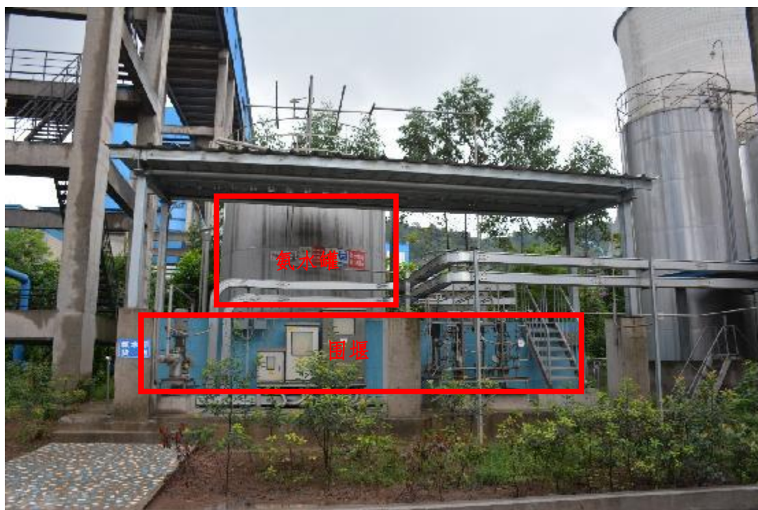
图 4.2-2 氨水储罐及围堰（依托）
