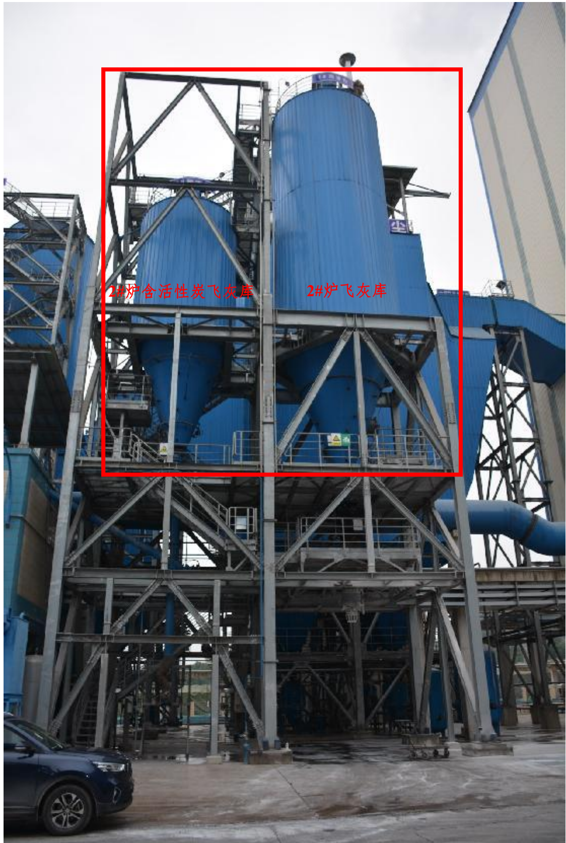
图 4.1-20 2#炉配套飞灰库
