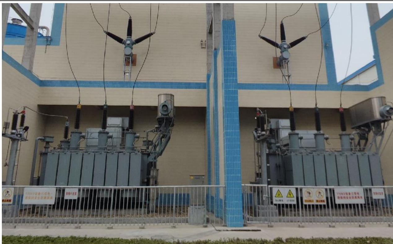
图6-1 2台变压器验收照片
