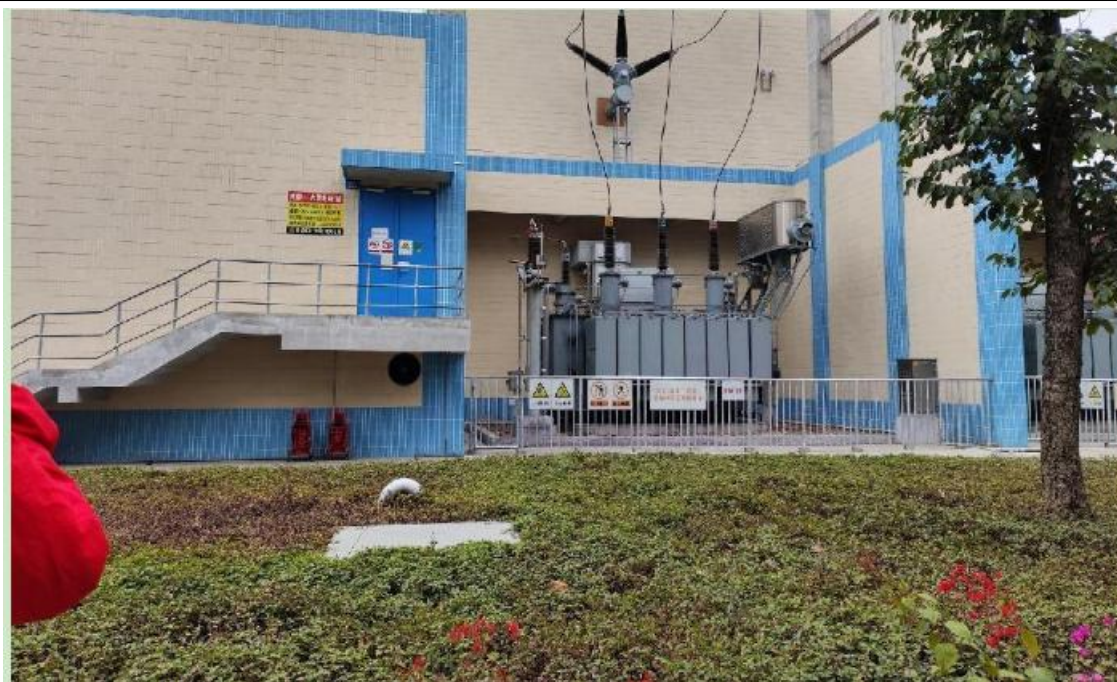
图6-2 事故油池及绿化现场照片
