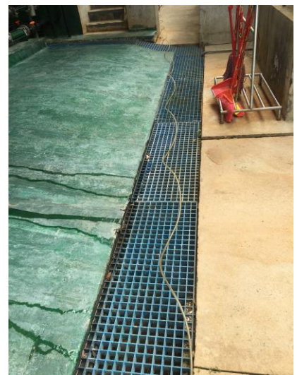
储罐区收集沟
