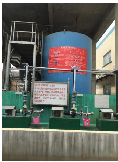
储罐区围堰
