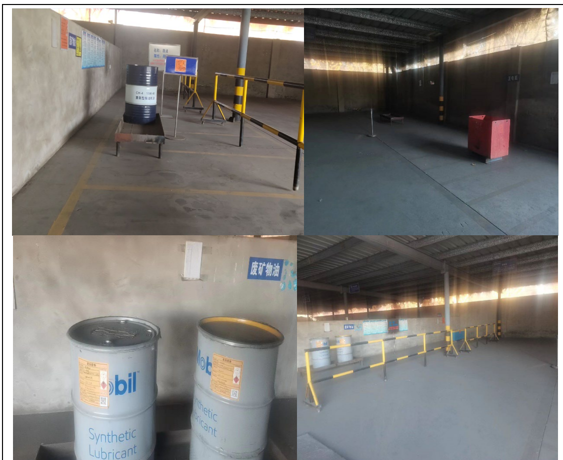
危废间地面、托盘、分类存放
