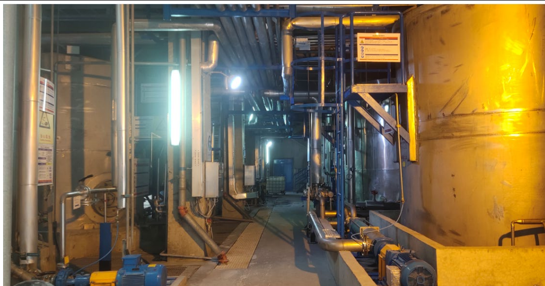
仓储部（液态辅料助剂）围堰
