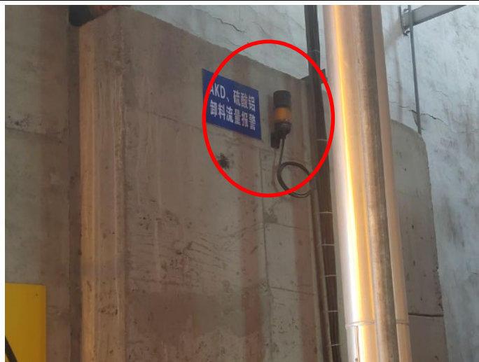
仓储部（液态辅料助剂）液位报警器
