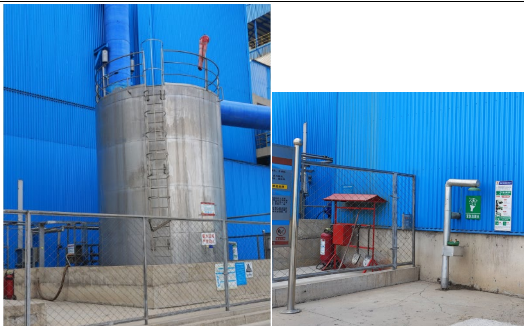
氨水罐围堰
