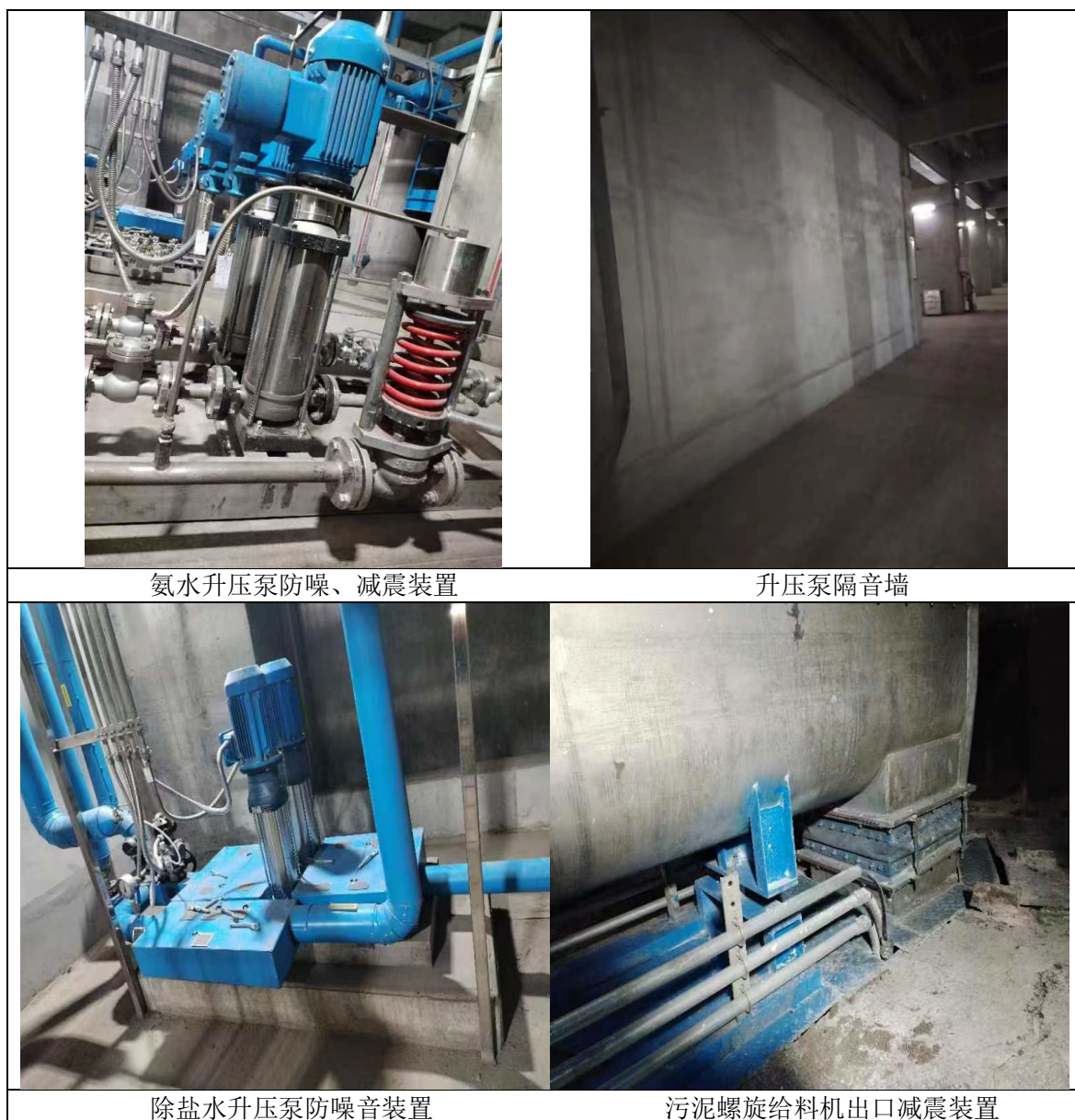
图 4-4 部分噪声源降噪措施
