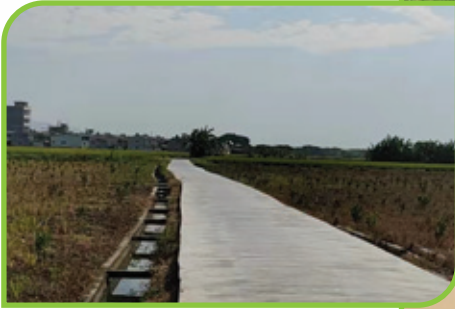
● 修繕村道 — 機耕路硬化
