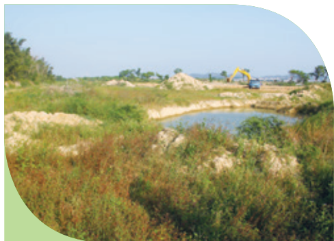
資助揭陽市惠來縣週田鎮杭美村修建玖龍蓄水陂
